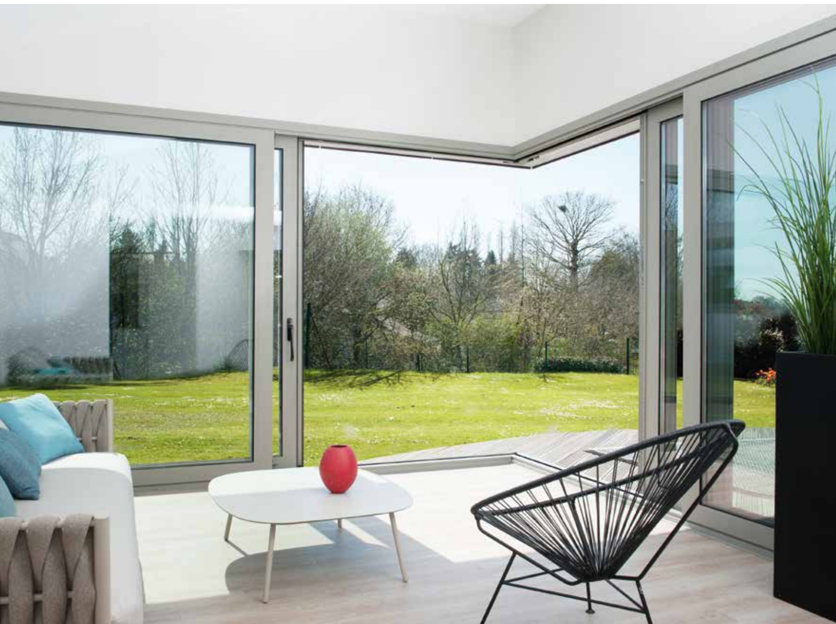
Ci-dessus, les châssis en aluminium des coulissants se rejoignent et ferment hermétiquement la façade sans poteau d'angle.
